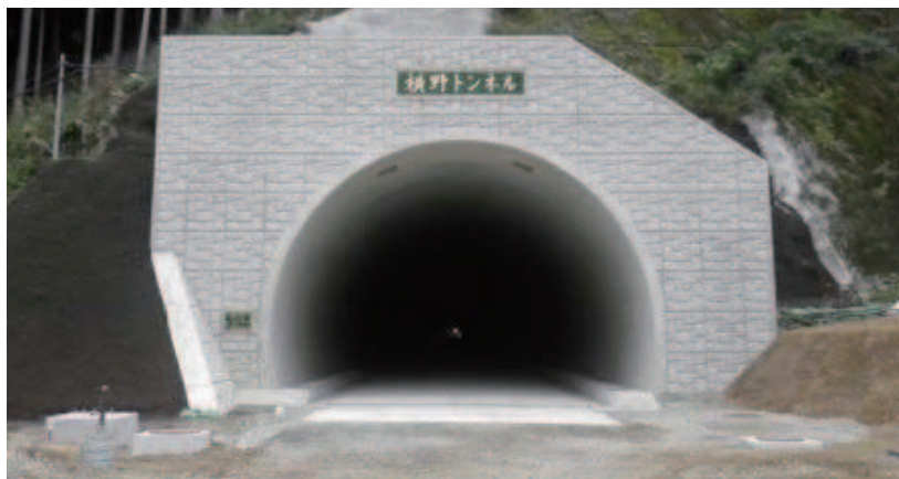
横野トンネル工事 [JV 工事] (宮崎県児湯郡西米良村)
