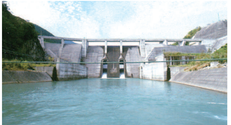
日南治水ダム工事 [JV 工事] (宮崎県日南市)
