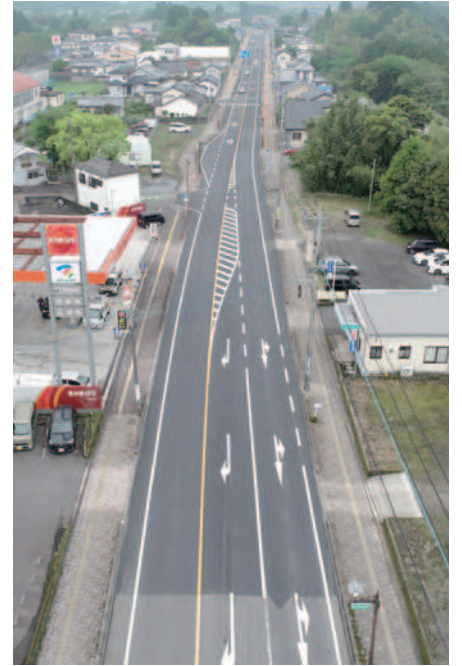
西麓工区舗装工事 (宮崎県西諸県郡高原町)
