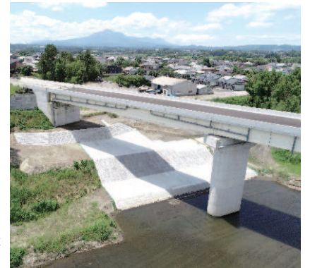
乙房地区護岸工事 (宮崎県都城市)
