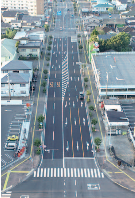
祝子前舗装工事 (宮崎県宮崎市)
