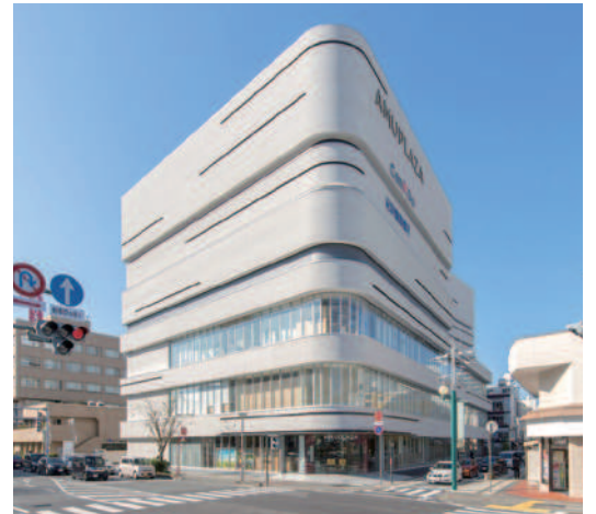
アミュプラザ やま館 [JV 工事] (宮崎県宮崎市)
