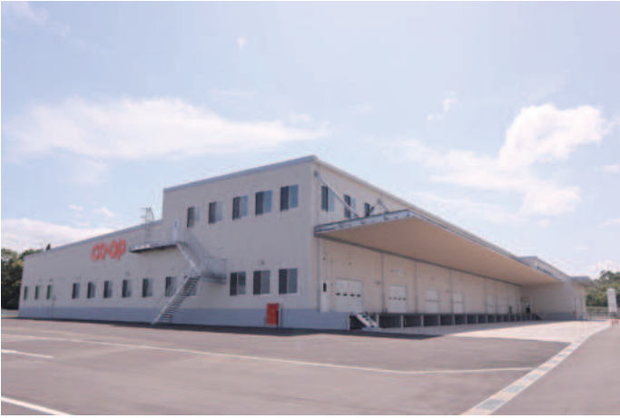
生活協同組合コープみやざき商品センター [JV 工事] (宮崎県宮崎市)
