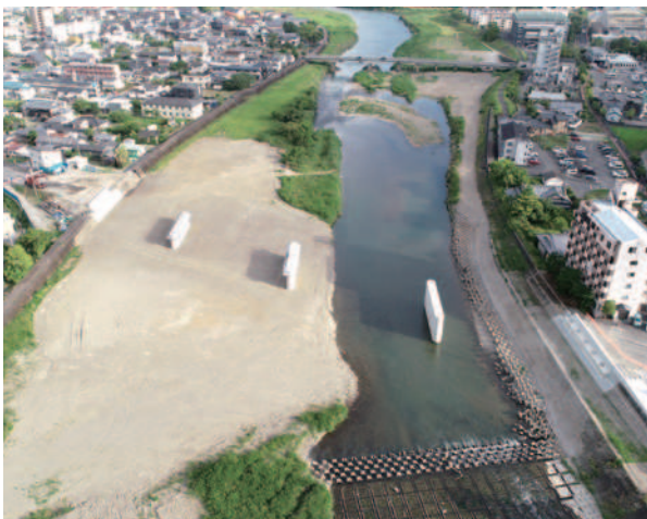
新町橋下部工事 [JV 工事] (宮崎県宮崎市)
