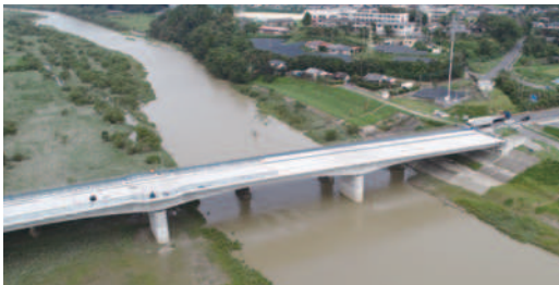
本庄橋上部工工事 [JV 工事] (宮崎県東諸県郡国富町)
