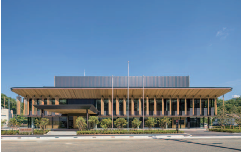
五ヶ瀬町役場新庁舎 [JV 工事]（宮崎県西臼杵郡五ヶ瀬町）
