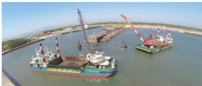
マリーナ浚渫工事 (宮崎県宮崎市)
