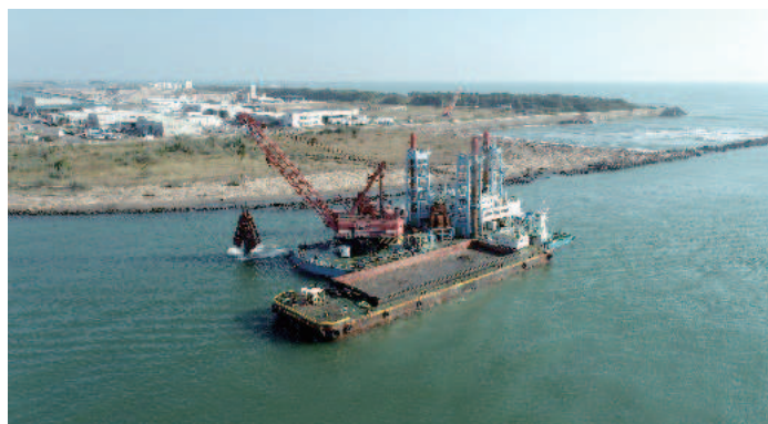
宮崎港浚渫工事 (宮崎県宮崎市)
