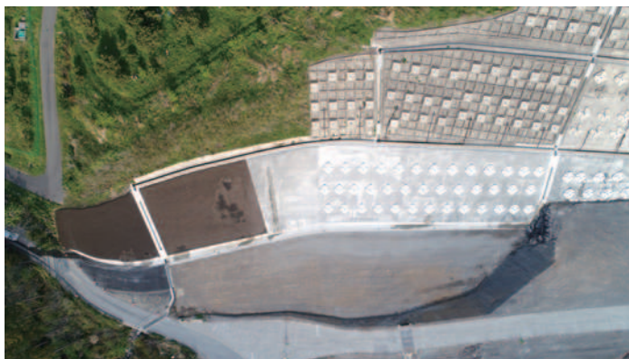
芳ノ元工区法面工事 (宮崎県宮崎市)
