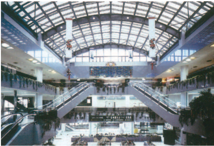
宮崎空港ターミナル [JV 工事] (宮崎県宮崎市)
