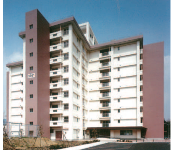
厚木米軍（5）高層住宅（神奈川県綾瀬市）
