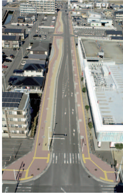
稗原歩道舗装工事 (宮崎県宮崎市)
