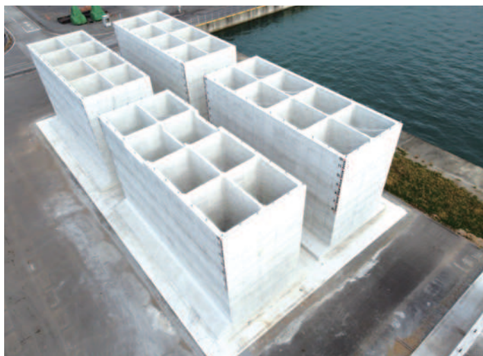
細島港ケーソン製作工事 (宮崎県日向市)
