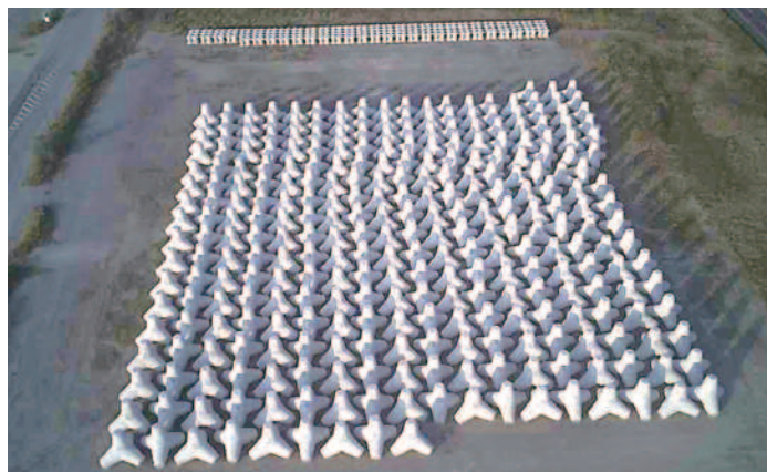
宮崎港ブロック製作工事 (宮崎県宮崎市)
