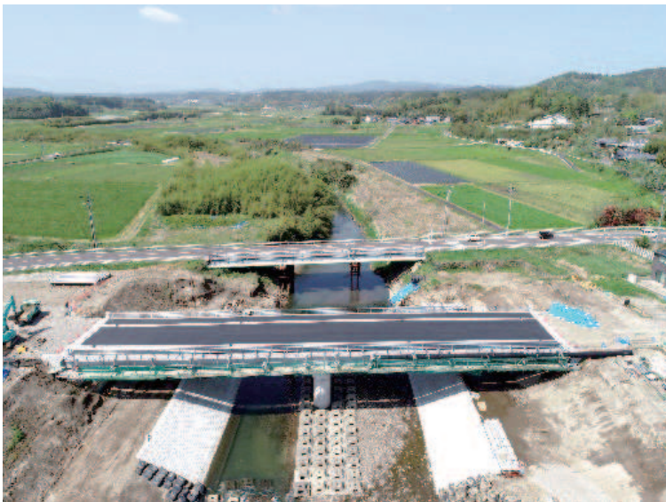
横市橋上部工工事 (宮崎県都城市)
