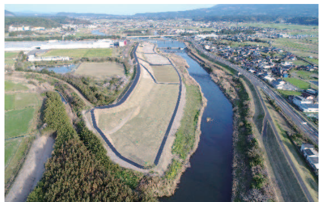
東川北環境整備工事 (宮崎県えびの市)
