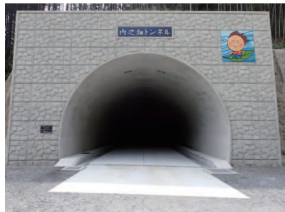
内之畑トンネル工事 [JV 工事] (宮崎県児湯郡 西米良村)
