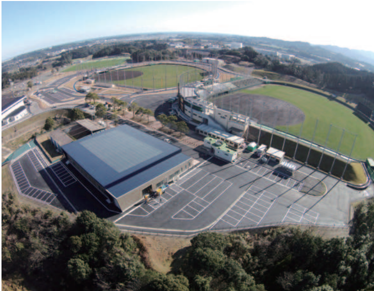
清武運動公園整備工事 (宮崎県宮崎市)
