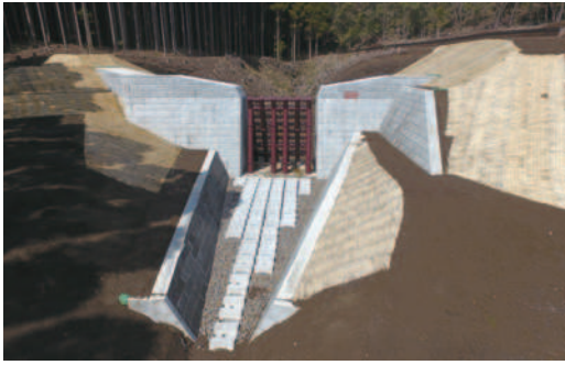
皇子川砂防堰堤工事 (宮崎県西諸県郡高原町)
