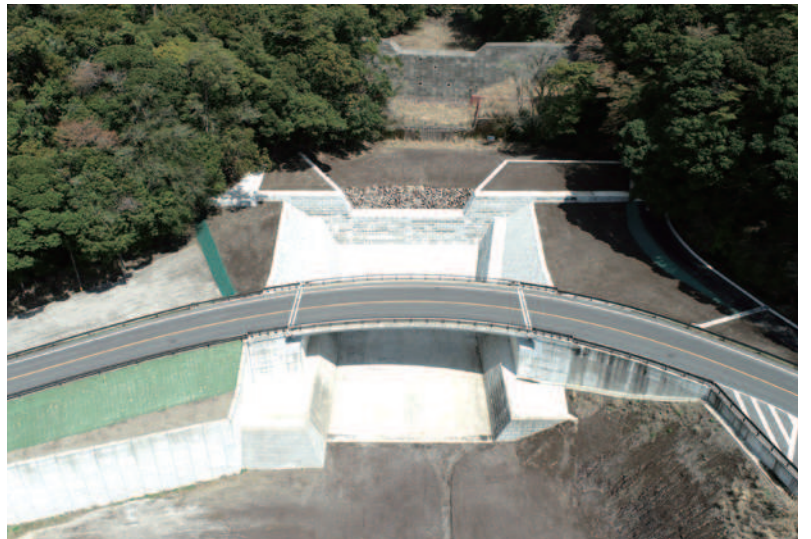
荒襲谷砂防工事 (宮崎県都城市)
